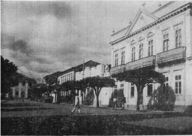
O edifício do Fórum, visto de outro ângulo, com sua fachada imponente, dominando um trecho da Praça 15 de Novembro
